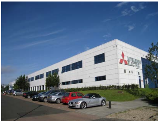
Air Con Factory 1
